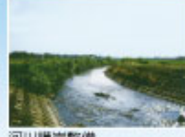
河川護岸整備
