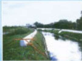
河川護岸改修
