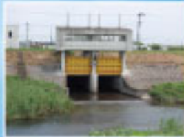
排水機場改修
