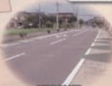
通字路安全対策
